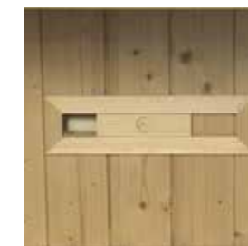
Camino per aerazione Ventilation grid
