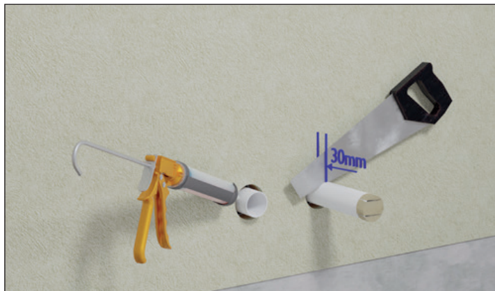
Fig. 54 Nach Aushärten des Montageschaums und Putzes sind anschließend die Rohre im Außenbereich mit einem Überstand von 30 mm gerade abzuschneiden (keinesfalls wandbündig abschneiden) und Schnittstellen zu entgraten, vorher sind die Rohrverschlüsse zu entfernen. Der Übergang zwischen Wand und Lüftungsrohren ist mit einem dauerelastischen Dichtstoff fachmännisch abzudichten.
